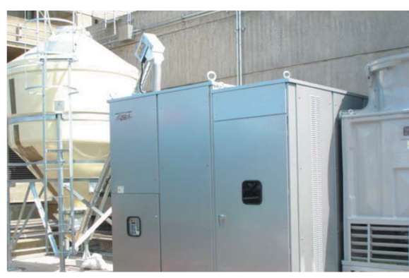
■ 京都大学宇治キャンパス 宇治市五ヶ庄 2011年4月導入 冷暖房 矢崎総業製 吸収式冷温水機
