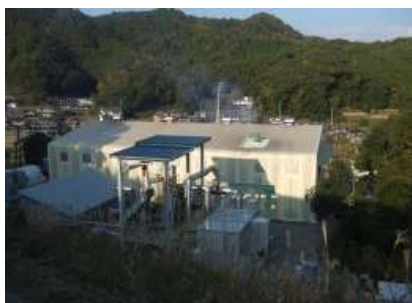
電気をペレット工場へ送るパイプ
