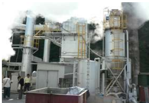
発電所の外観
