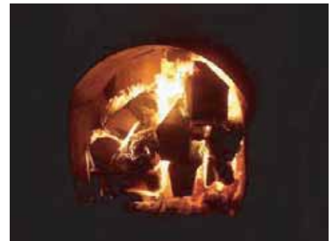
ボイラーで燃える薪。ボイラーの近くはとても暑い。
