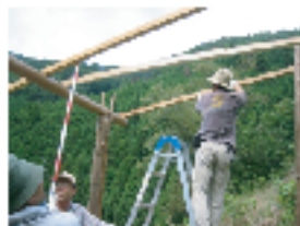
⑥2つの梁に桁材を渡して いき、どちらかに傾斜を つける。
