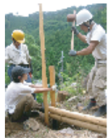
④柱と杭をかけやを 使って打ち込む。
