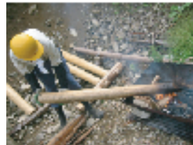
③柱や壁をはさむ杭を 焼いて防腐加工する。
