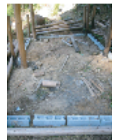
⑤壁の土台となる ブロックを敷く。
