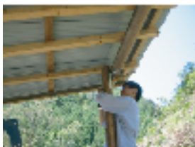
⑦梁と柱を金具や木材で補強 する。トタン屋根は10cmぐ らい重ねて並べる。
