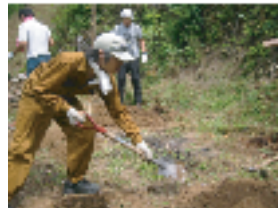
②柱と杭を入れる穴を 1mほど掘る。
